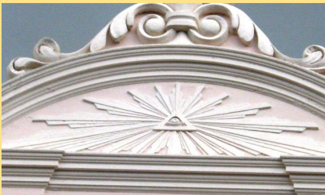
Santa Casa de Misericórdia de Pelotas.
